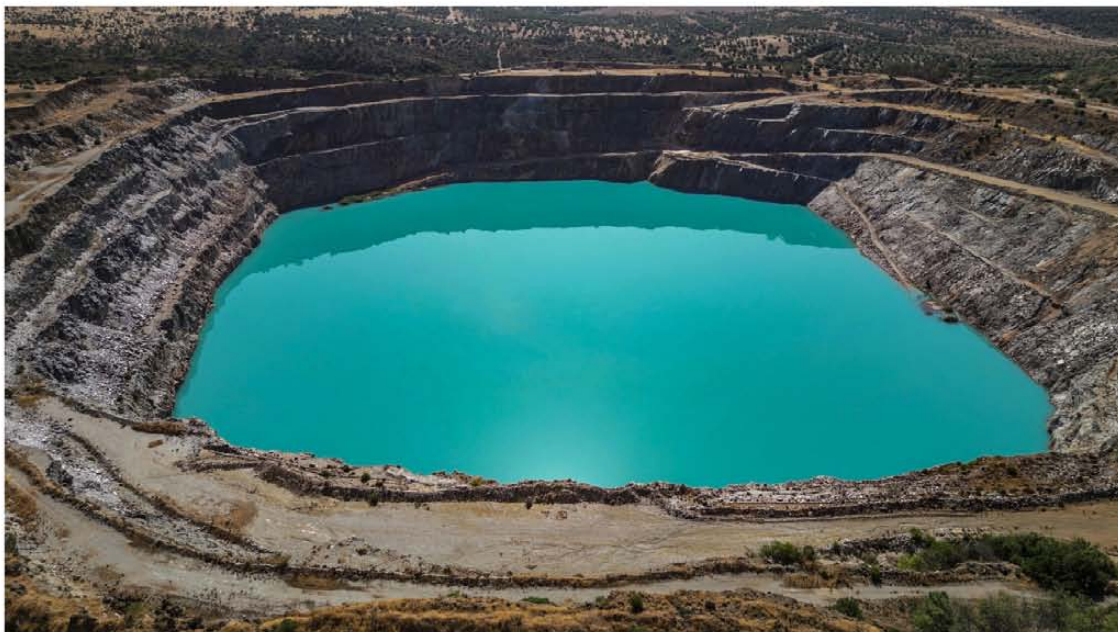
La Corta de Los Frailes será depurada y rehabilitada junto a su entorno antes del comienzo de la explotación por parte la empresa Minera los Frailes, dentro del proyecto de explotación y restauración de la mina de Aznalcóllar (Sevilla). EFE/José Manuel Vidal
