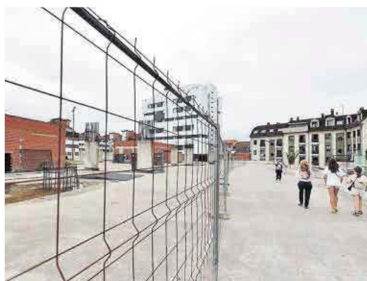
Vandantes pasan junto a la zona vallada en la que acaban de comenzar las obras de las dos nuevas torres del Vasco. | Irma Collin
