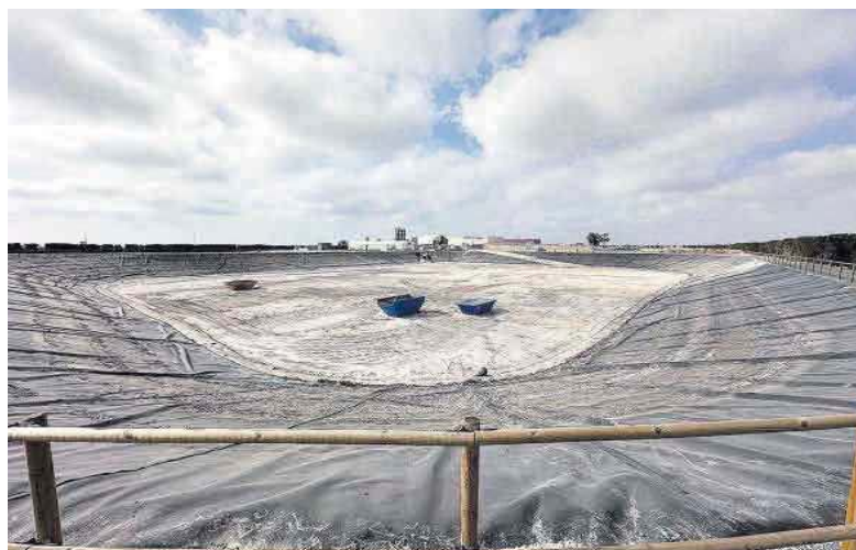
Las obras terminadas de la EDAR de San Javier.
